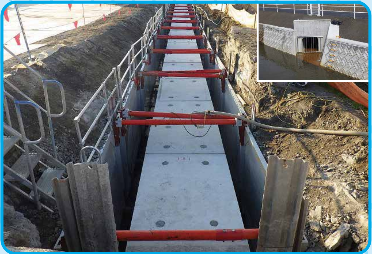
写真／県営湛水防除事業「逆川地区」導水路工事
